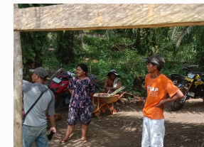
임마누엘 교회의 공사 재개.
