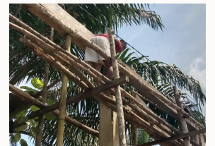
지붕 공사를 위해 기둥 작업 시작
